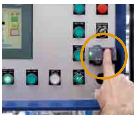
制御盤やコントロールパネルの 操作制限
